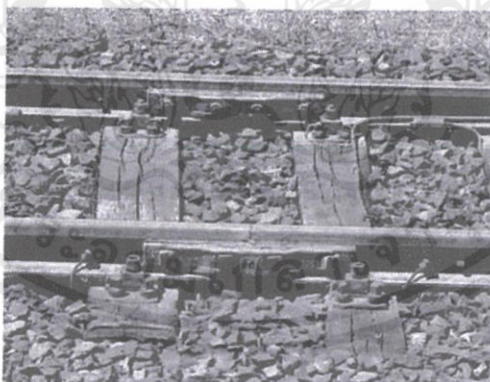
รูปที่ 2.4 รางรถไฟถูกคั่นด้วยฉนวนไฟฟ้าเพื่อแบ่งตอนของทางออกจากกัน
