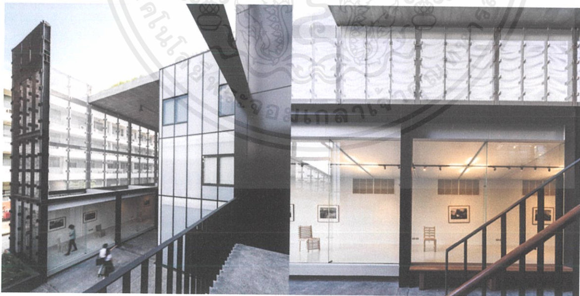
ภาพที่ 1.57 รูปบริเวณอาคาร
