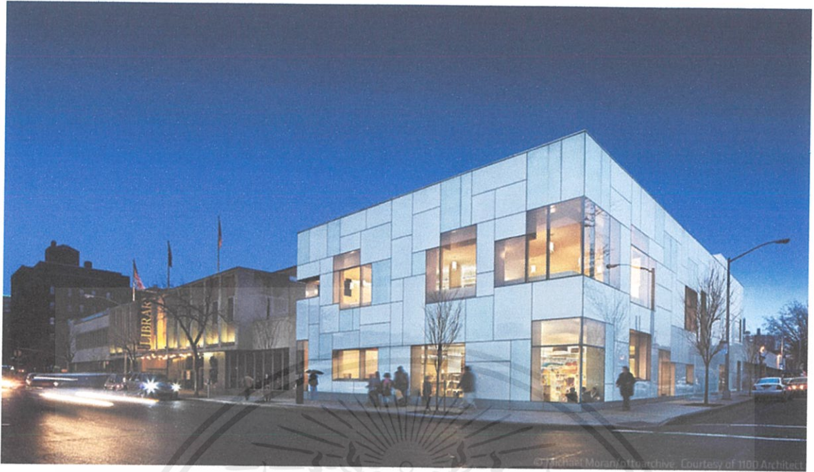
ภาพที่ 2.43 รูปอาคาร
