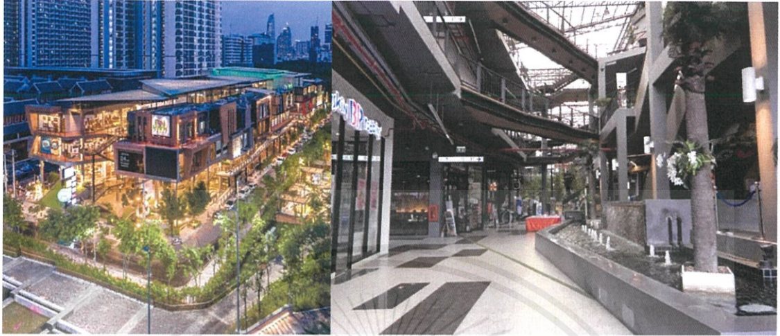
รูปลักษณะอาคาร I'M PARK
