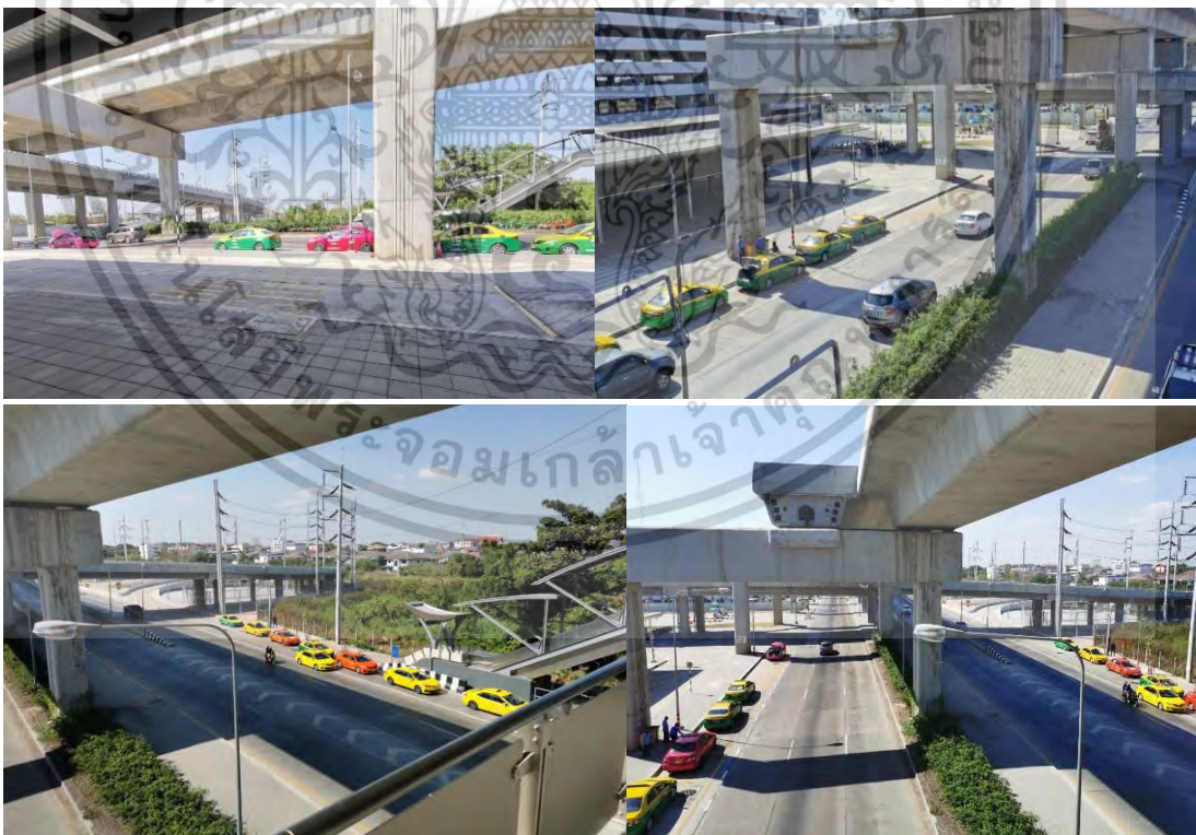
รูปที่ 4.11 จุดจอดรถแท็กซี่และรถประจำทาง
