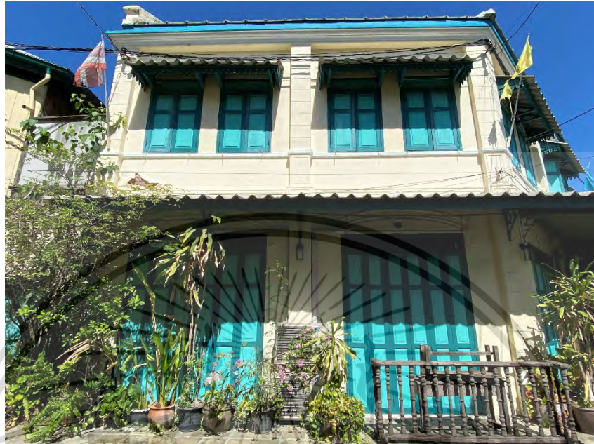
รูปที่ 4.2 แสดงรูปด้านหน้าอาคาร The Bhuthorn ที่มา : ผู้วิจัย (2564)
