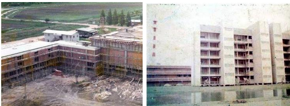
ภาพที่ 4.3 เริ่มก่อสร้างอาคารเรียนของสถาบันเทคโนโลยีพระจอมเกล้าเจ้าคุณทหารลาดกระบัง
