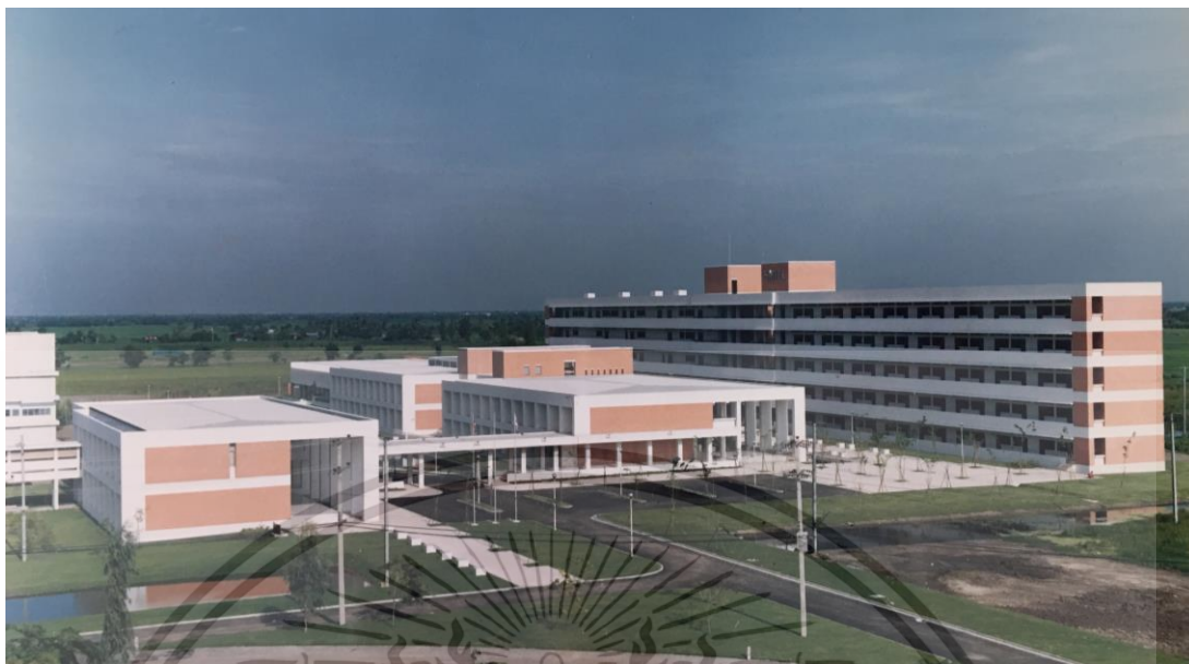
ภาพที่ 5.1 อาคารเรียนรวมสมเด็จพระเทพฯ ก่อสร้างแล้วเสร็จเมื่อปี พ.ศ.2529 ที่มา : King Mongkut's Institute of Technology Ladkrabang (KMITL), THE EXPANSION OF KING MONGKUT'S INSTITUTE OF TECHNOLOGY IN THE KINGDOM OF THAILAND PRINCESS MAHA CHAKRI ACADEMIC CENTRE 1986
