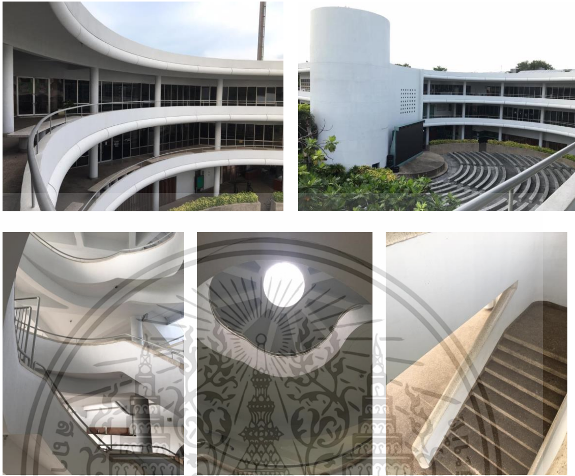
ภาพที่ 2.8 อาคารศูนย์เยาวชนกรุงเทพมหานคร ที่มา : ผู้วิจัย
