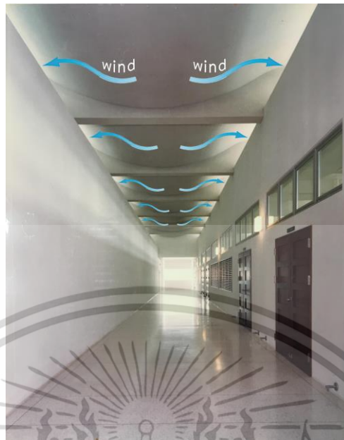
ภาพที่ 5.26 แสดงการระบายอากาศใต้หลังคาของอาคารเรียนรวมสมเด็จพระเทพรัตนราชสุดา สถาบันเทคโนโลยีพระจอมเกล้า เจ้าคุณทหารลาดกระบัง ที่มา : ผู้วิจัย
