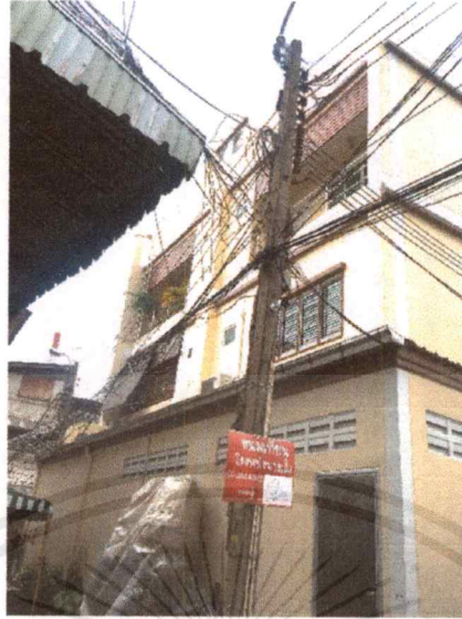
ภาพที่ 1.15 แสดงภาพอาคารหอพัก
