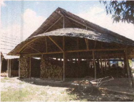
รูปที่ 3. 34 รูปแสดงโรงแช่ไม้ในกระบวนการรักษาเนื้อไม้และโรงสำหรับเก็บไม้ที่ผ่านกระบวนการฯ ถ่ายเมื่อ ตุลาคม 2560
