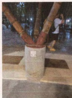
รูปที่ 7.13 รูปแสดงรอยต่อเหล็กที่ใช้ในโครงสร้างไม้ไผ่ รอยต่ออาคารศูนย์กีฬา โรงเรียนมีชัยพัฒนา ถ่ายเมื่อ 12 ส.ค. 2560
