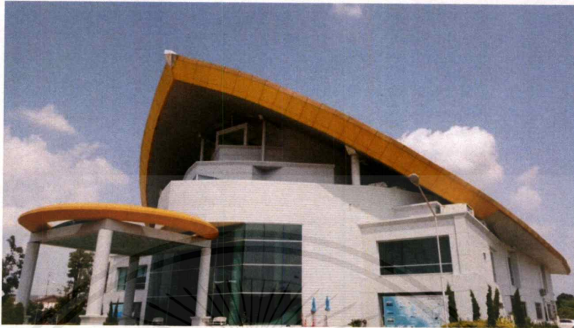
รูปที่ 3.7 ทางเข้าของโครงการ
