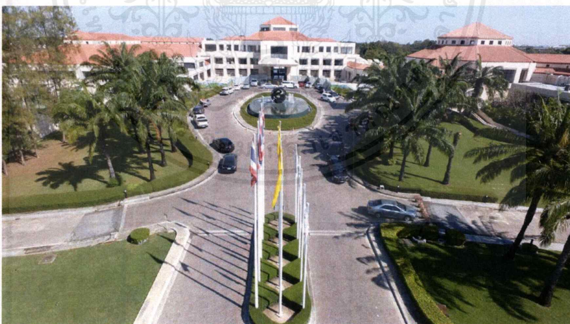
ภาพที่ 1.7.2.4 ภาพรวมอาคารทั้งหมด
