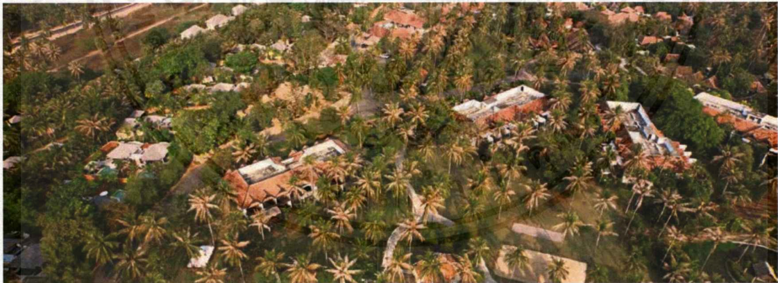
ภาพที่ 1.7 ภาพมุมมองด้านบนบริเวณอาคารห้องพัก
