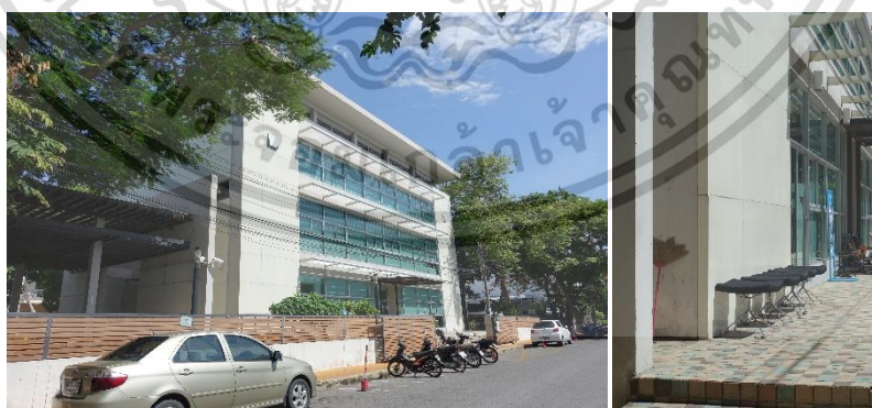
ภาพที่ 4.12 วัสดุเปลือกอาคารประกอบด้วยผนังกระจกทางด้านหน้าและด้านหลังของอาคาร และผนังอิฐฉาบปูนเรียบกรุอลูมิเนียมคอมโพสิตทางด้านข้างของอาคารทั้งสองฝั่ง
