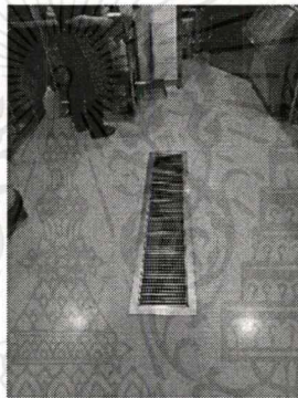
ภาพที่ 3 - 44 แสดงตะแกรงสำหรับน้ำทิ้งจากการทำความสะอาดพื้น
