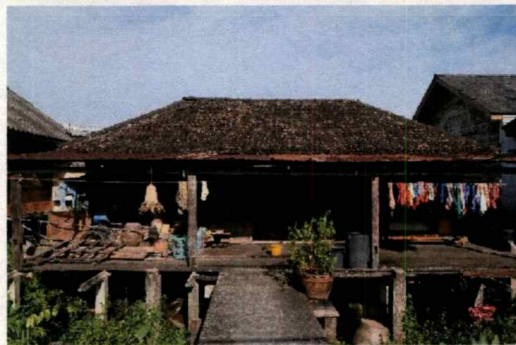
รูปที่ 7.3 รูปแบบสถาปัตยกรรมพื้นถิ่นภาคใต้
