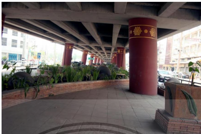
ภาพที่ 2.9 การจัดภูมิทัศน์ใต้สะพานข้ามแยกหนองหอย (โดยผู้วิจัย ถ่ายเมื่อ 28 มกราคม 2556)
