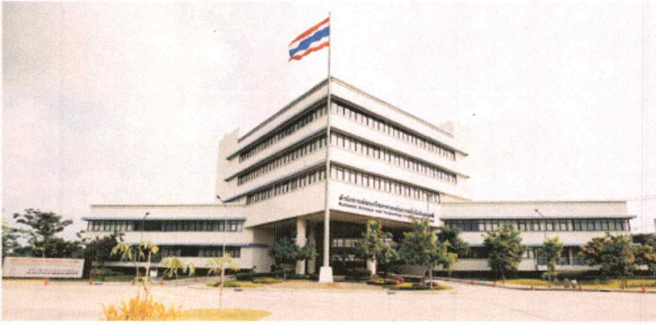
รูปที่ 1.7.12 อาคารภายนอก
