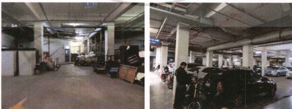
รูปที่ 1.7.16 ลานจอดรถชั้นใต้ดิน
