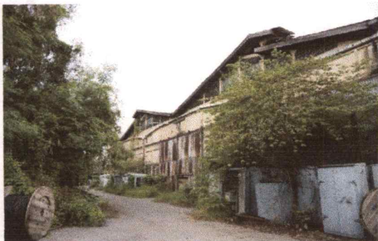
ภาพที่ 1.39 อาคารโกดังเก็บคลังพัสดุ
