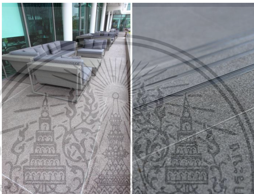
ภาพที่ 8. 7 ภาพพื้นหินขัด และ ลักษณะรอยต่อ ที่มา : SCG Home ปี 2563
