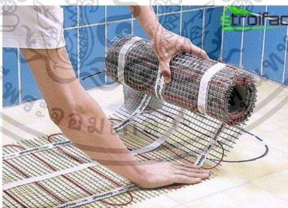
งานติดตั้งพื้นไฟฟ้า
