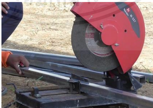
รูปที่ 3.13 ตัดเหล็ก
