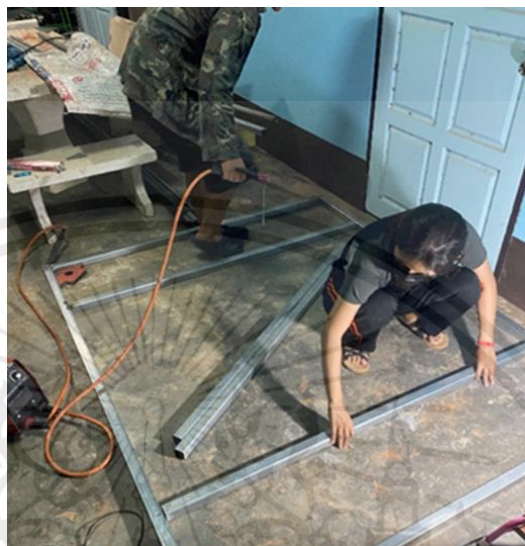
รูปที่ 3.14 ตั้งเหล็กให้มีระยะห่างกัน 40 cm
