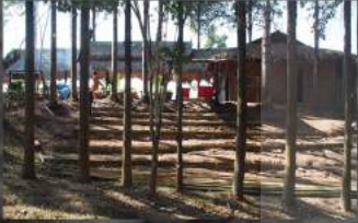
อาคารอนุประสงค์ ร้านค้าชุมชน
