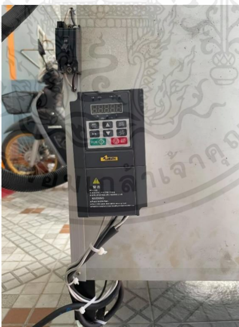
รูปที่ ก.9 ติดตั้งอินเวอร์เตอร์
