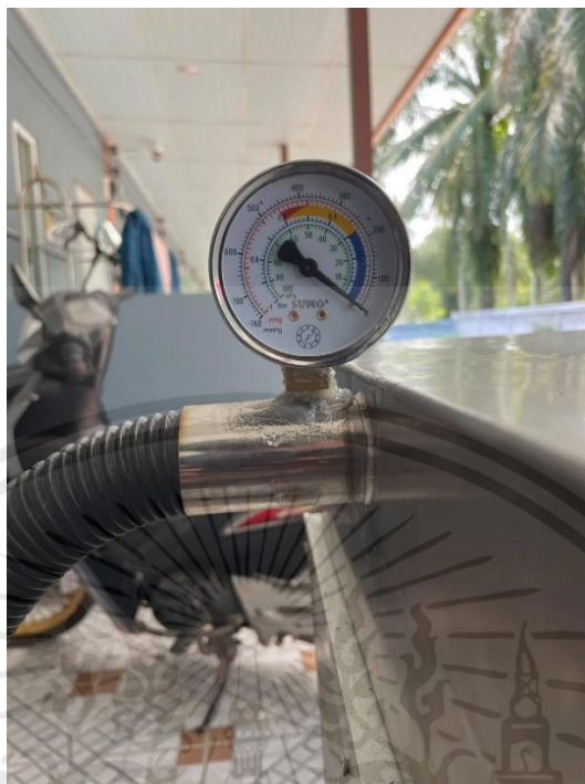
รูปที่ ก.10 ติดตั้งเกจวัดความดัน
