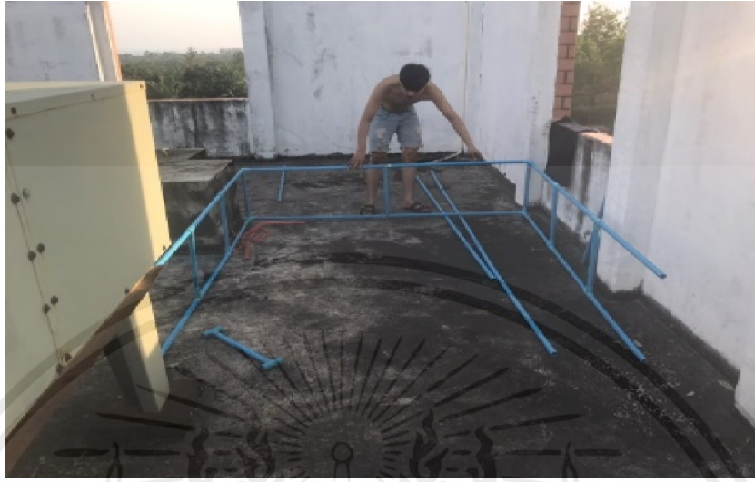
รูปที่ ค.11 สร้างโครงสร้างรางรับน้ำ
