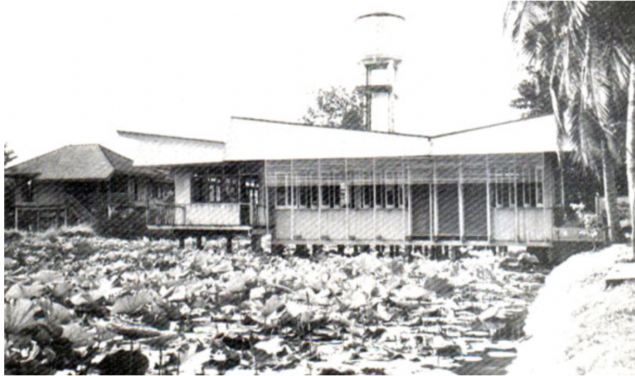
ภาพที่ C แสดงภาพอาคารในอดีต ที่มา : สำนักงานเขตมินบุรี
