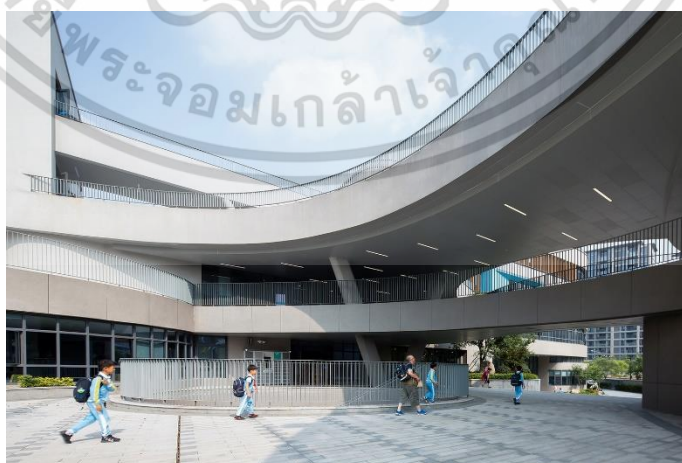
รูปที่ 3.47 : แสดงทัศนียภาพภายในบริเวณทางเชื่อมอาคาร
