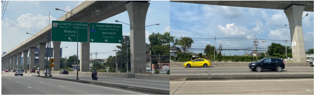
รูปที่ 7.16 มุมมองถนนหน้าโครงการ (ที่มา : อภิขญา บัวแก้ว บันทึกภาพเมื่อ 2 พฤศจิกายน 2563)
