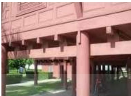
รูปที่ 8.2 : แสดงโครงสร้าง เสา คาน ตงไม้ (ที่มา : http://www.tatc.ac.th/files/ สืบค้นวันที่ 4 ธันวาคม 2563)
