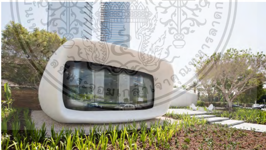
รูปที่ 8.6 ตัวอย่างอาคารที่ใช้การก่อสร้างจากวัสดุ 3D printing
