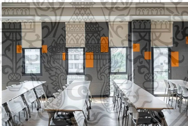
ภาพที่ 6.9 ตัวอย่างวัสดุอะคูสติคดูดซับเสียงในห้องบรรยาย
