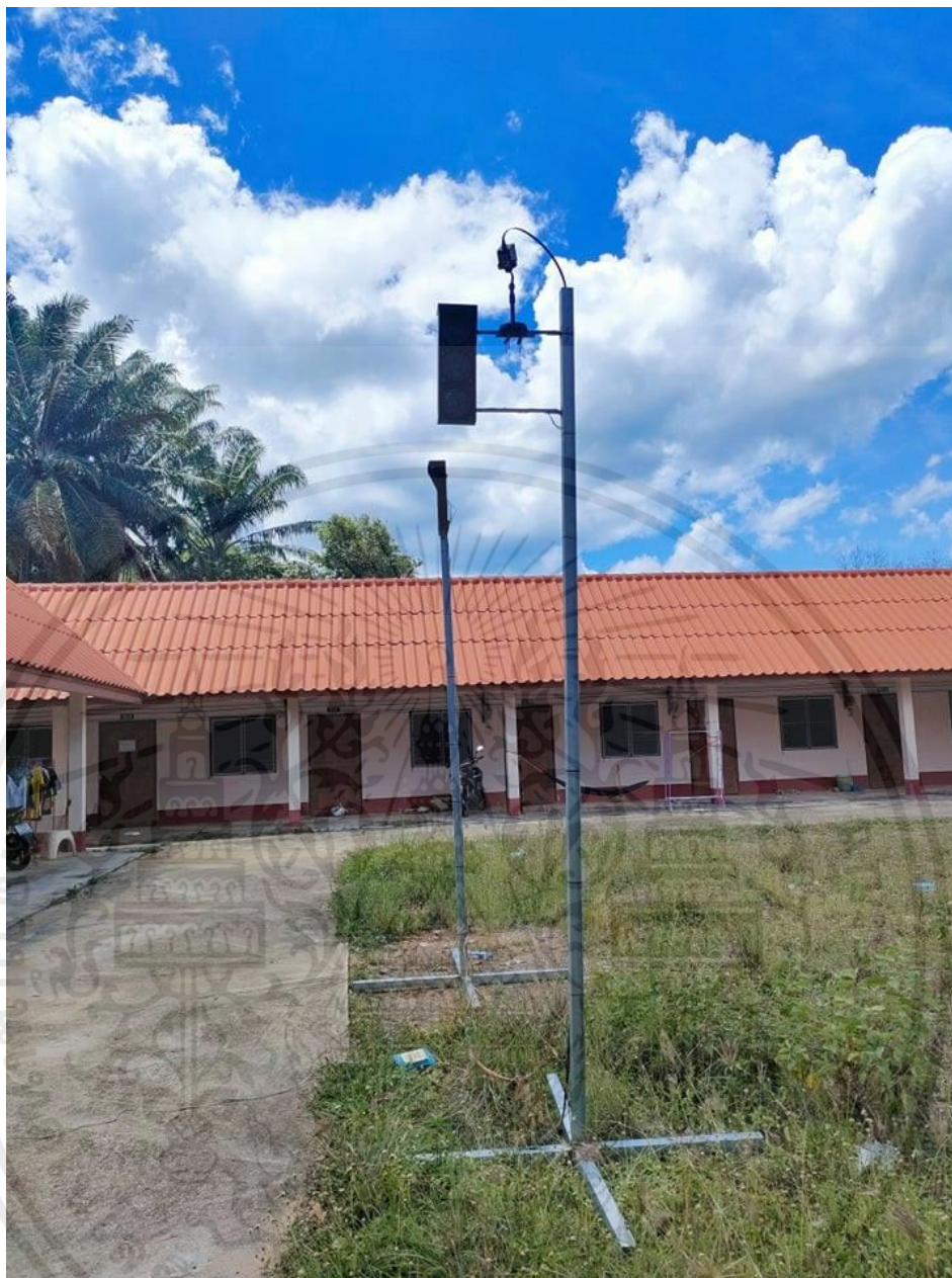
รูปที่ 3.21 ไฟจราจร
