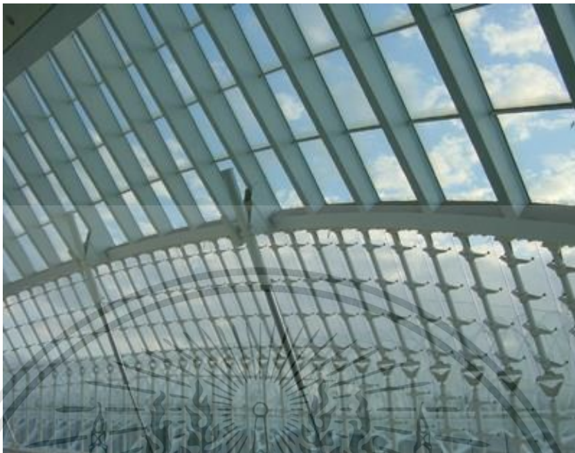
ภาพที่ 3.20 แสดงการใช้ระบบ ไฮโดรลิคของอาคาร City of Arts and Sciences (ที่มา : www.dphotographer.co.uk สืบค้นวันที่ 20 พฤศจิกายน 2563)
