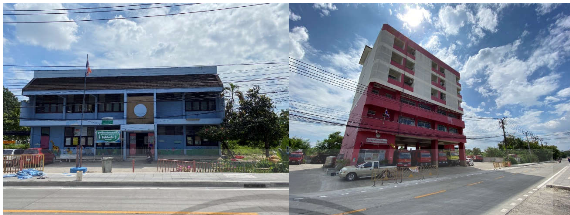
รูปที่ 3-28 มุมมองฝั่งตรงข้ามจากไซด์ด้านใน (สำนักงานเก่าและดับเพลิง) (4) (ที่มา: ผู้จัดทำ)
