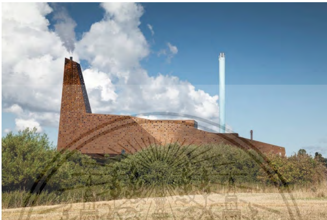
ภาพที่ 3-14 Incineration Line in Roskilde, Denmark (Source : Erick van Egeraat)
