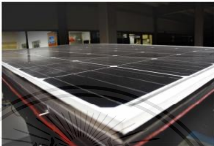
รูปที่ 3.8 แผงโซลาร์เซลล์ ติดตั้งบนหลังคารถไฟไฟฟ้า
