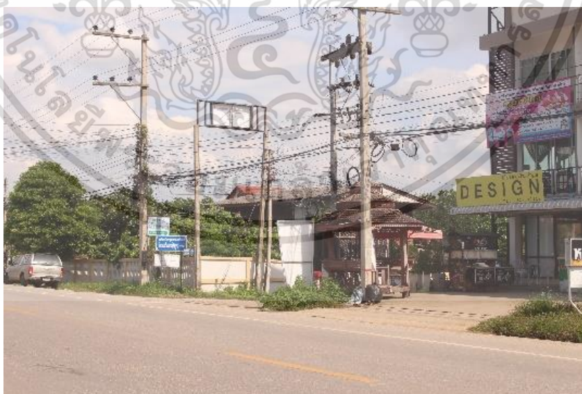
รูปที่ 6.14 ถนนหน้าโครงการ และบรรยากาศบริเวณหน้าโครงการ (ที่มา : ธัญพิชชา ปัญญาของ 2563)
