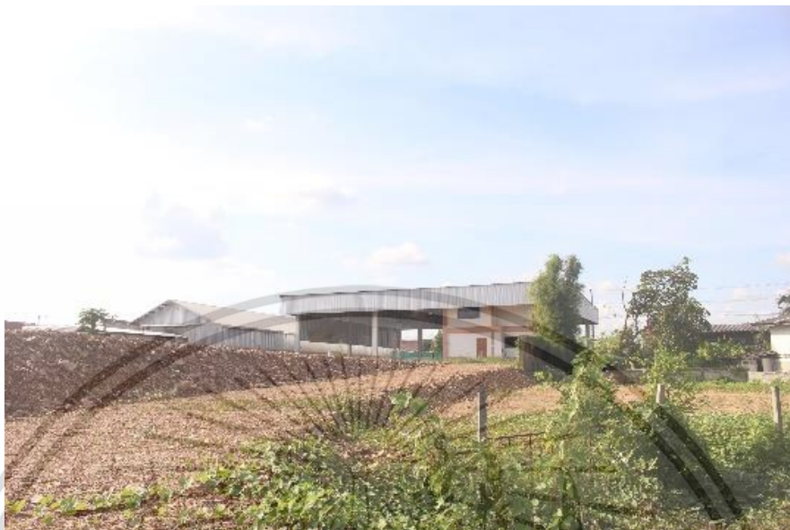
รูปที่ 6.15 ถนนหน้าโครงการ และบรรยากาศบริเวณหน้าโครงการ (ที่มา : รัญพิชชา ปัญญาของ 2563)
