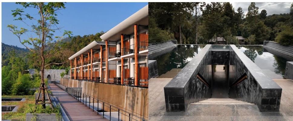
ภาพที่ 3.8 ภาพบรรยากาศของโครงการส่วนที่เป็นกำแพงก่อนเข้าอาคารที่พัก
