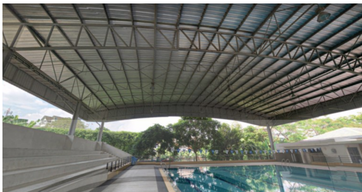
ภาพที่3.11 แสดงโครงสร้างอาคารสระว่ายน้ำ (ที่มา : นางสาวณัฐธิดา โกไศยกานนท์ 2563)
