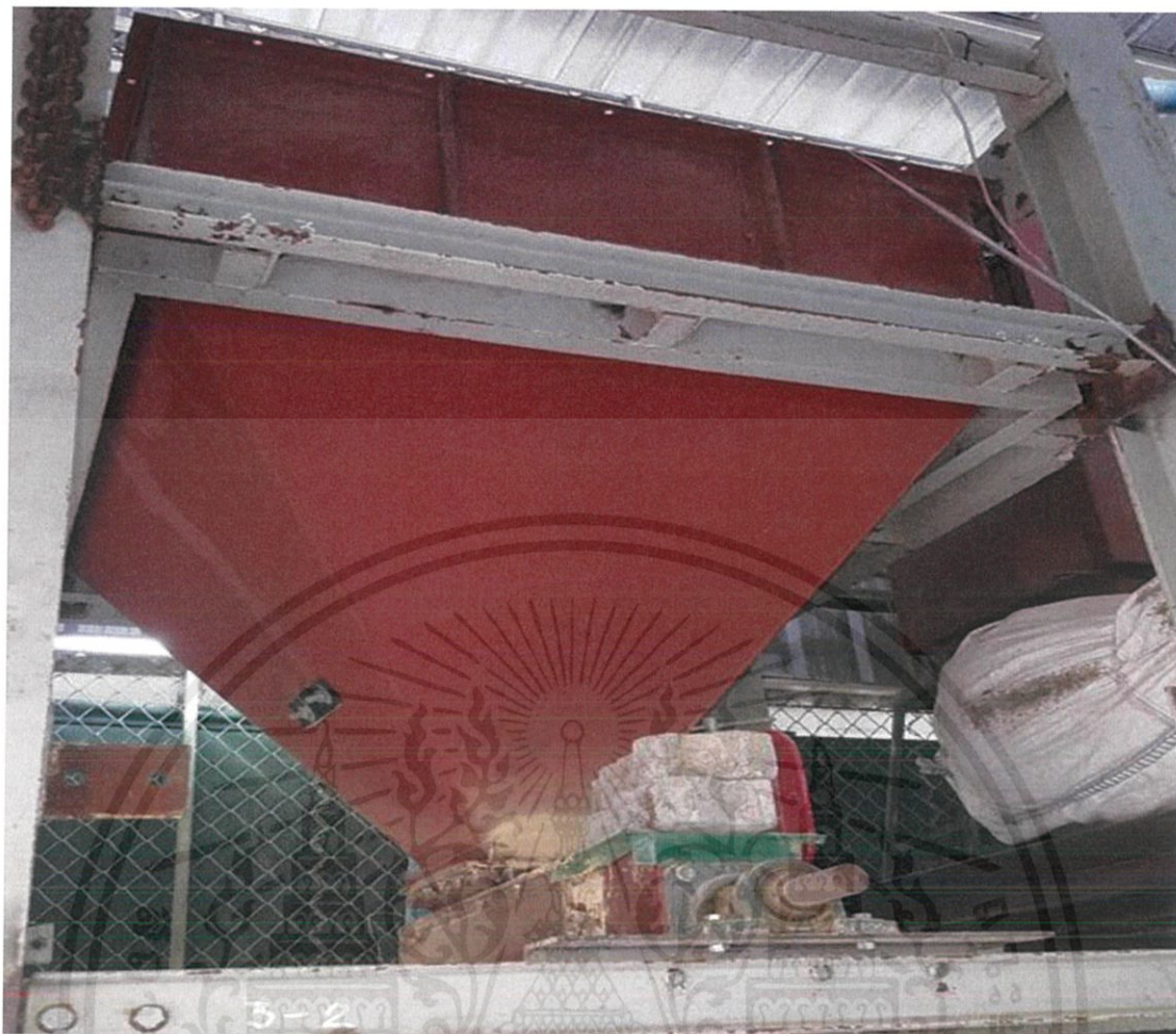
รูปที่ ข.2 แสดงลักษณะฮอปเปอร์เก็บเชื้อเพลิงอัดเม็ด (Hopper pellet fuel)
