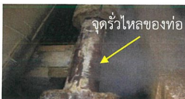
รูปที่ 1.1 ท่อตรงที่เสื่อมสภาพ และเกิดการรั่วขึ้น
