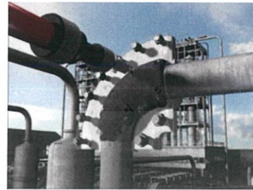
รูปที่ 2.4 อัดผลิตภัณฑ์จนเต็มร่อง (The Colt Group, 2012)
