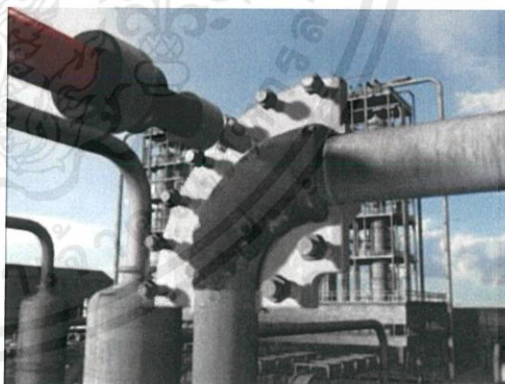
รูปที่ 2.10 อัดผลิตภัณฑ์จนเต็มร่องน้ำยา
