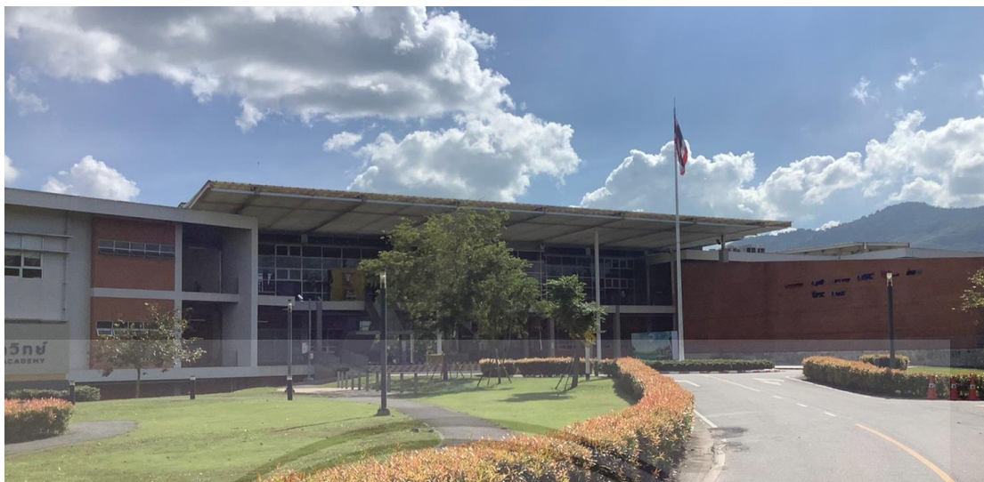
รูปที่ 3.1 แสดงทัศนียภาพอาคารเรียนโรงเรียนกำเนิดวิทย์
