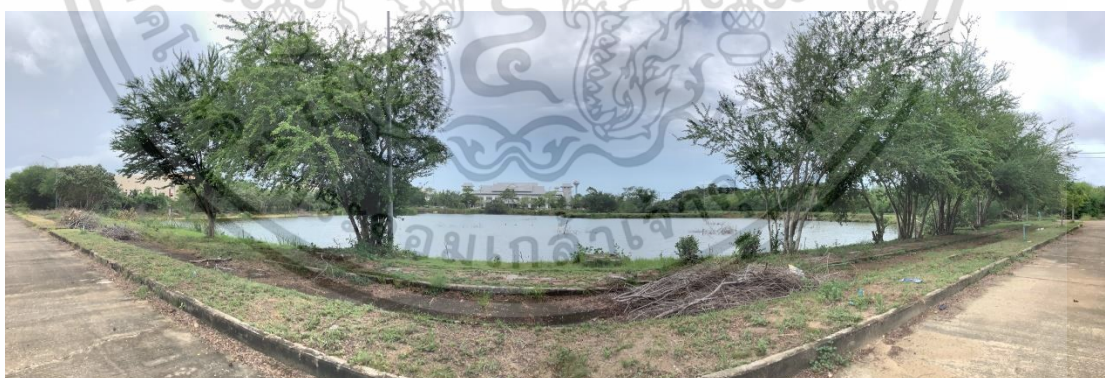
รูปที่ 6.9 แสดงภาพมุมกว้างจากถนนด้านทิศใต้
