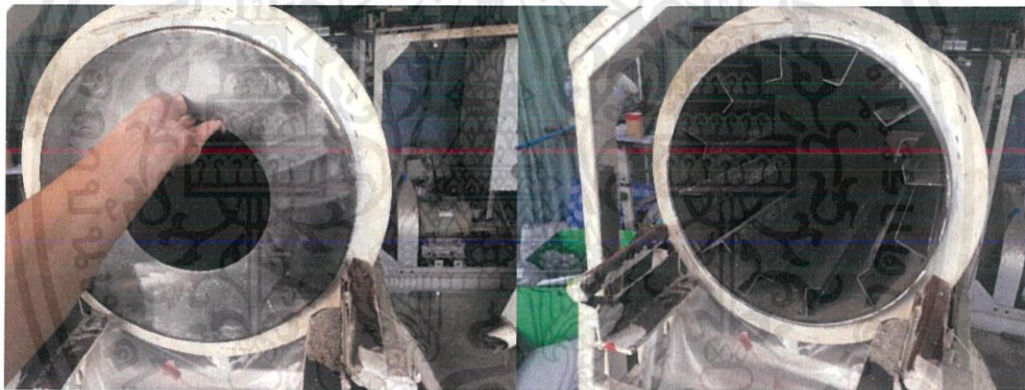
รูปที่ 4.22 ถังเตาอบด้านปลายก่อนและหลังตัดฝาปิด
