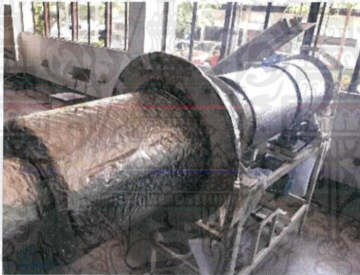
รูปที่ 4.25 ถังเตาอบและท่อลมหลังจากทำการหุ้มฉนวน
