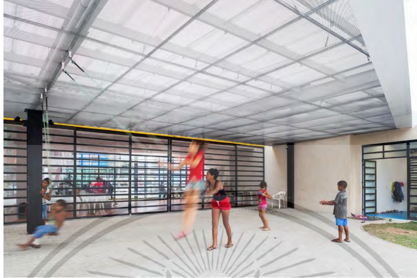
รูปที่ 4.9 แสดงการใช้วัสดุโปร่งแสงบริเวณหลังคา (ที่มา : https://www.archdaily.com/ สืบค้นวันที่ 22 กันยายน พ.ศ.2563)
