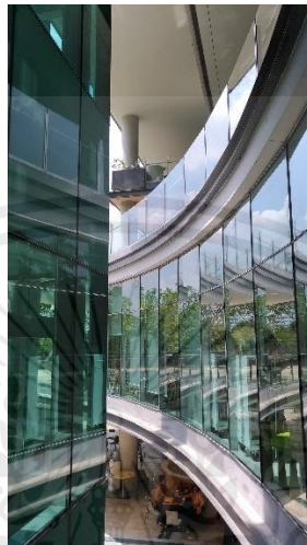
ภาพที่ 4-123 กระจกสองชั้นโลว์-อี (Low-E Double Glass) อาคารศูนย์เรียนรู้สุขภาวะ สสส. ที่มา: ชัยสิทธิ์ ใจกล้า ถ่ายเมื่อวันที่ 10 ตุลาคม พ.ศ.2563
