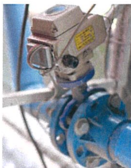
รูปที่ 4.23 วาล์วปีกผีเสื้อ (butterfly valve)
