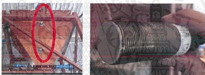
รูปที่ 4.3 ถังเก็บเชื้อเพลิงผง ที่ตำแหน่งการติดตั้งอุปกรณ์วัดระดับเชื้อเพลิงผง
