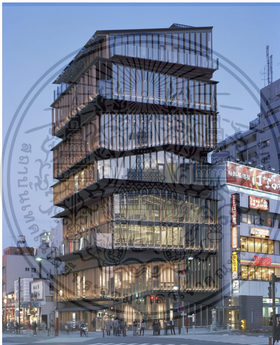
รูปที่ 3.10 รูปทัศนียภาพภายนอกโครงการ
