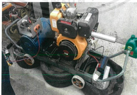
รูปที่ 3.2 generator และ เครื่องยนต์ ที่ใช้ในการทดลอง
