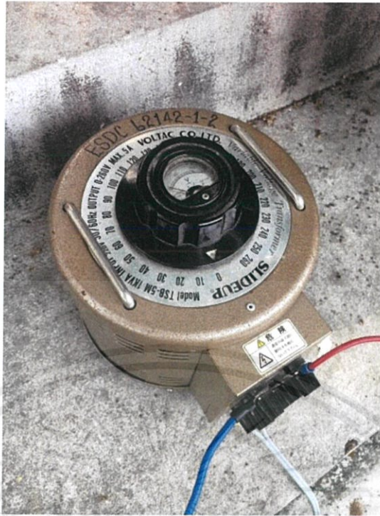
รูปที่ 3.7 Auto Transformer
