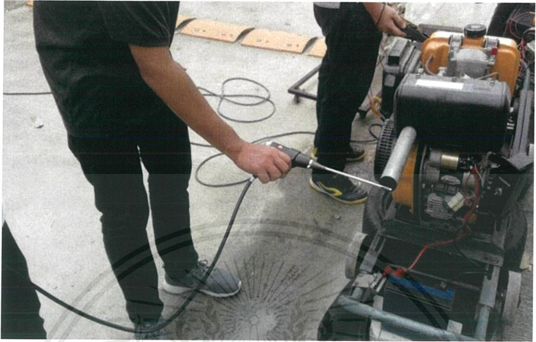
รูปที่ 3.10 การวัดสารเคมี ณ ปากปล่องเครื่องยนต์
