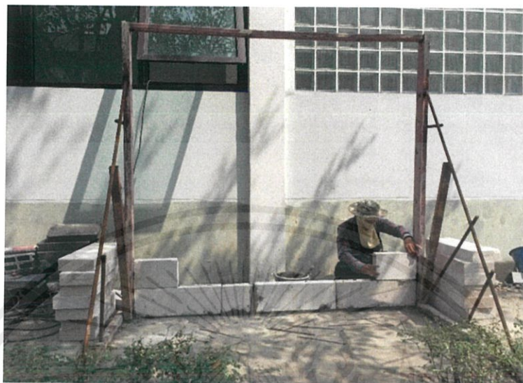
รูปที่ 3.9 การค้ำยันบริเวณเสาเหล็ก
