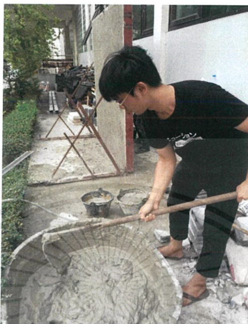
รูปที่ 3.13 การผสมปูนฉาบสำเร็จรูป
