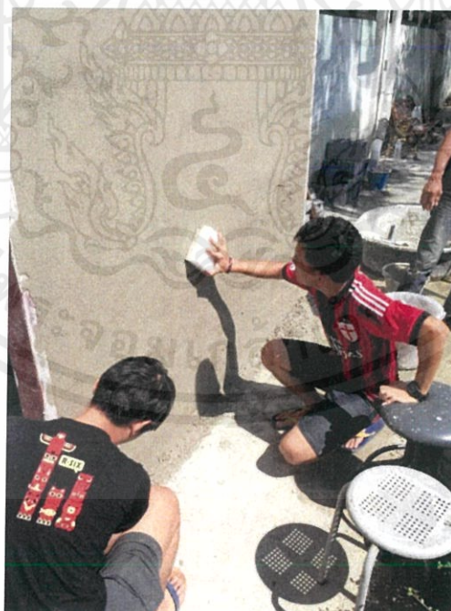
รูปที่ 3.16 การตกแต่งงานฉาบให้สวยงามโดยการปั้นปูน
