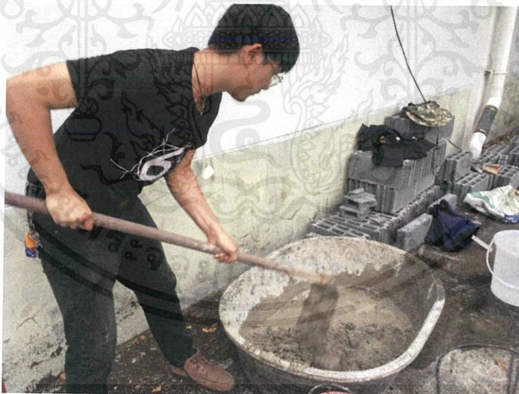
รูปที่ 3.4 การผสมปูนก่อสำเร็จรูป
