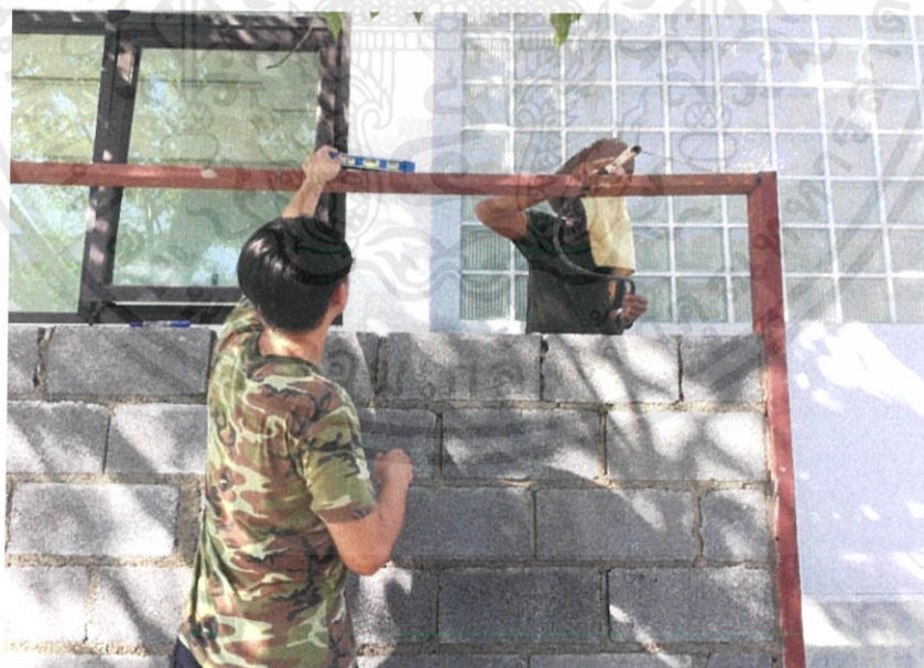
รูปที่ 3.10 การติดตั้งทับหลังเหล็ก
