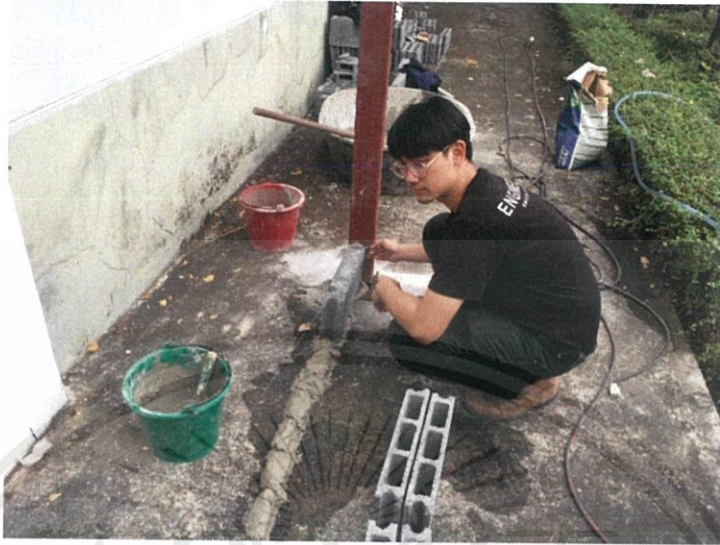
รูปที่ 3.3 การวางแนวการก่ออิฐโดยใช้เส้นเอ็น
