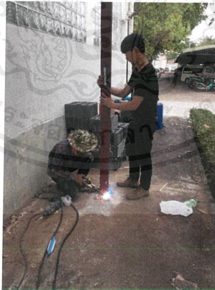
รูปที่ 3.2 การเชื่อมติด Plate เหล็ก กับเสาเหล็ก
