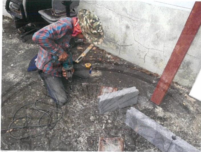
รูปที่ 3.1 การเจาะพื้นโดยใช้สว่าน
