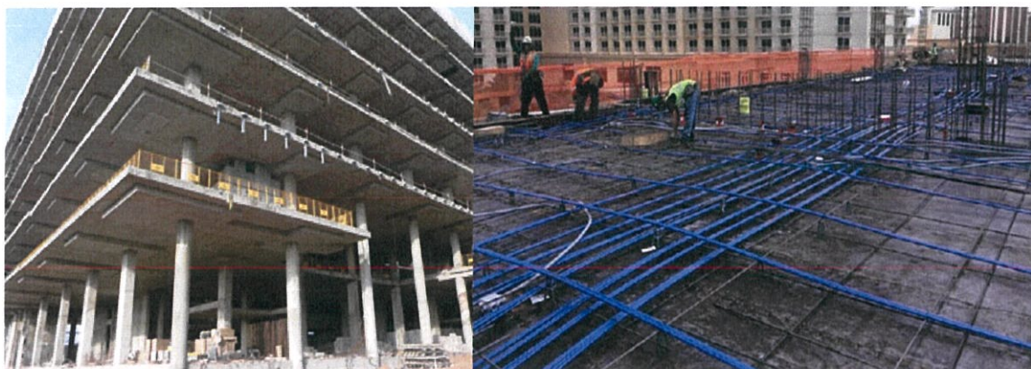
ภาพที่ 8.1 แสดงโครงสร้างพื้น Post Tension และการก่อสร้างพื้น Post Tension (ที่มา http://www.poonmix.com/ready-mix-concrete/e7dfdบักคอนกรีตอัดแรง.html )
