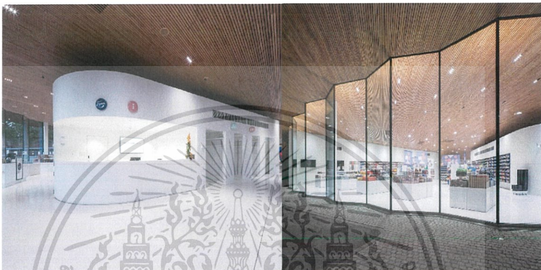
ภาพที่ 4.11 แสดง ฝ้าไม้ที่นำวัสดุท้องถิ่นมาใช้ องค์ประกอบอาคาร
