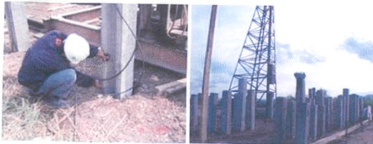
รูปที่ 7.1 แสดงขั้นตอนในการทำเสาเข็มตอก
