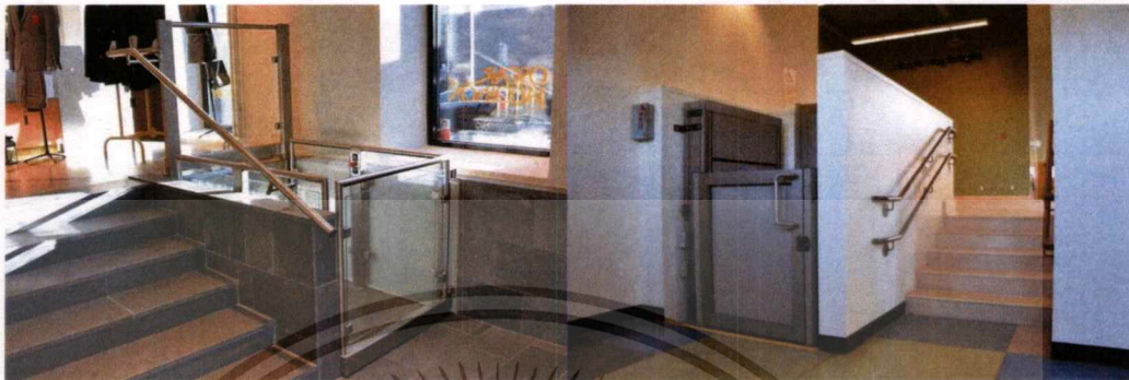
ภาพที่ 7.20 ตัวอย่างลิฟท์ยกด้วยระบบไฮดรอลิก (Hydraulic Platform Lift)
