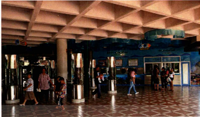
ภาพที่ 2.12 แสดงโครงสร้างพื้นแบบ waffle slab
