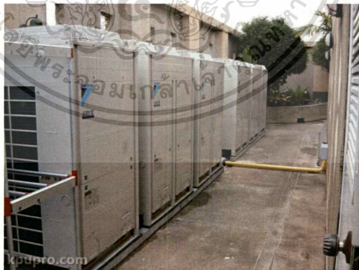
รูปที่ 6-3 ภาพแสดงการติดตั้ง condensing unit
